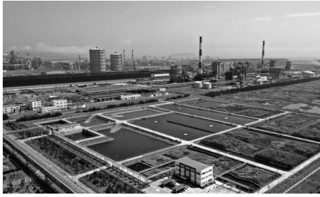
▲ IESE thiết kế, thi công Hệ thống hồ sinh học & bãi lọc trồng cây kiểm soát sự cố do nước thải công nghiệp
