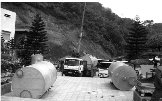
▲ Lắp đặt Bể xử lý nước thải chế tạo sẵn cho khu Đền Thượng, Tây Thiên, Vĩnh Phúc
